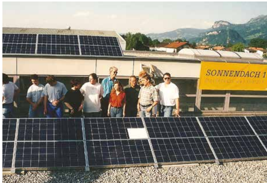
1997 Die Fotovoltaik Anlage wird in Betrieb genommen.
